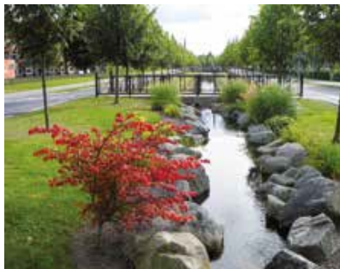
Öppen avledning istället för kulverterad.
