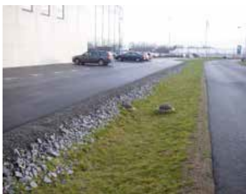
Fördröjning av dagvatten från P-yta
