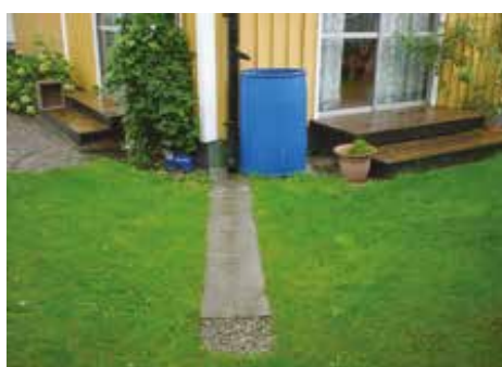
Utledning av takvatten på gräsmatta
