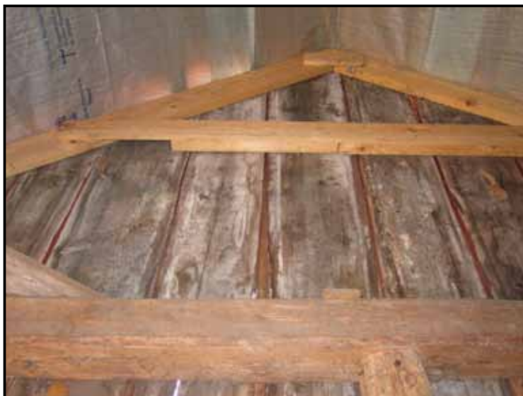
Uthuset är uppfört av återanvänt material från en äldre riven byggnad, bland annat ett ramsågat bräddtak.
