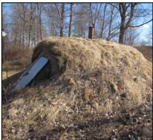
Den sentida matkällaren i gjuten betong.
