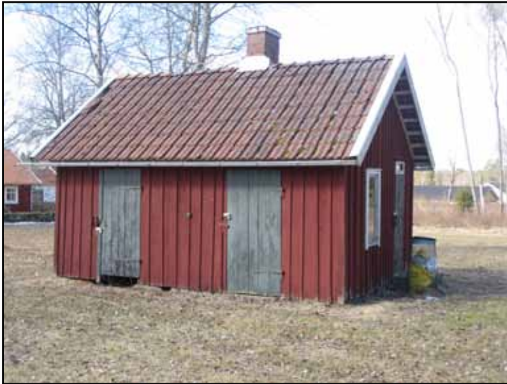
Uthuset ger vid först anblicken intrycket av ålder men är uppfört i relativt sen tid.
