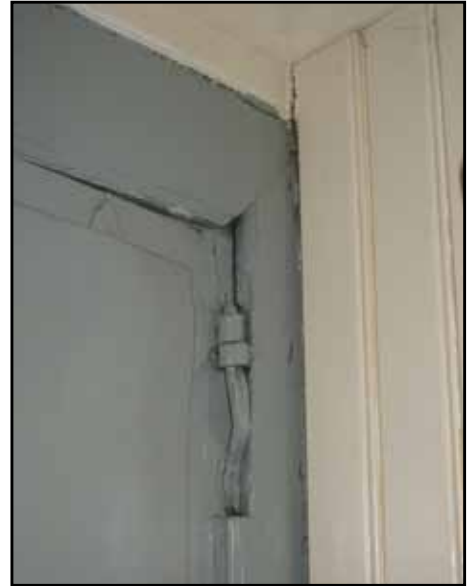
Innerdörrarna är original med smidda plattgångjärn men har sekundärt klätts med masonit.
