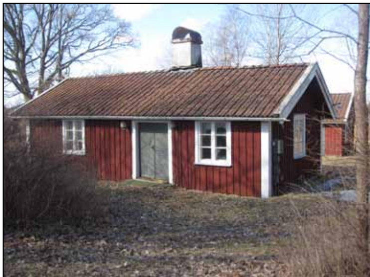
Torpet Lundabo ligger utmed en bevarad sträckning av gamla Nissastigen i Gislaveds södra del.
