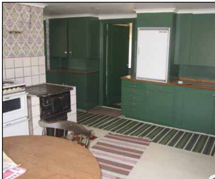
Den platsbyggda köksinredningen och vedspisen är från 1950-talet. Köket kläddes då med ljus gul masonite. På 1980-talet renoverades köket i allmogermantisk stil.
