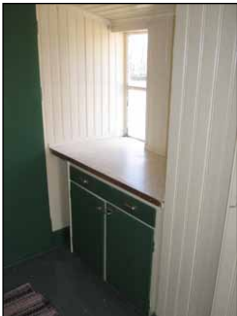
Köksförstugan med pärlspånspanel 1910-talet och platsbyggt underskåp från 1950-talet.
