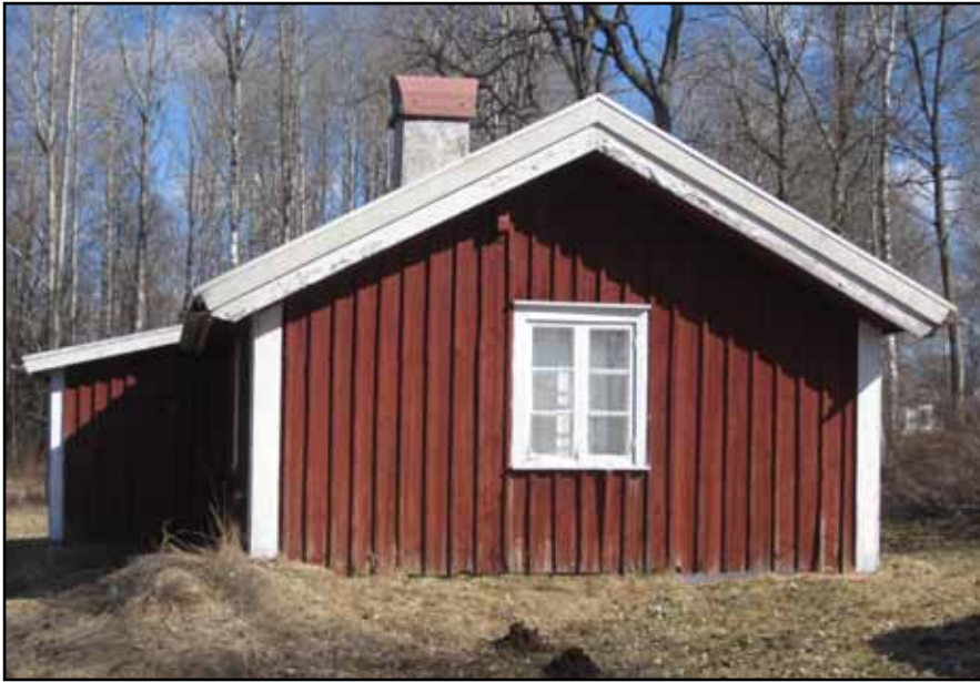
Den cirkelsågade fasadpanelen från 1930-talet har ett äldre, mer levande utseende eftersom man återanvänt enstaka äldre panelbrädor. Torpet hade fram till på 1930-talet inga markerade, vitmålade, hörn- och fönsterfoder.
