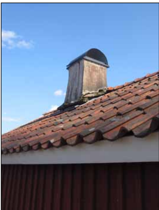
Skorstenen som liksom stugans öppna spisel murades upp 1933 är något konkav till sin form. Den har ett utskjutande skift med stenar vid basen, vilket var en vanlig typ av anslutning mot torvtak under förindustriell tid. Skorstenen är sedan 30-talet cementputsad och vitmålad samt har ett sentida plåtsvep av standardmodell.
