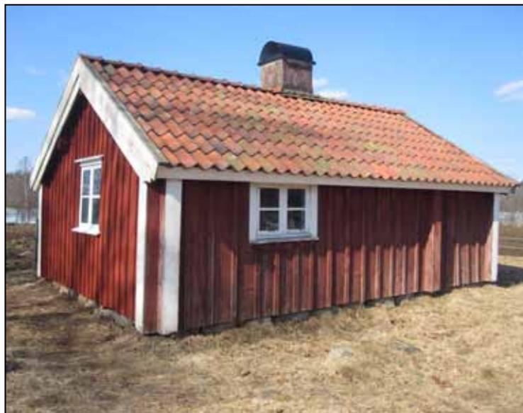
Brädfodring kan för det ovana ögat lätt misstas att vara från 1800-talet. Den tillkom 1933 men utfördes då med äldre förebilder. Tyvärr kopierades den inte fullt ut vid de nyligen utförda fasadarbetena på västra gaveln.
