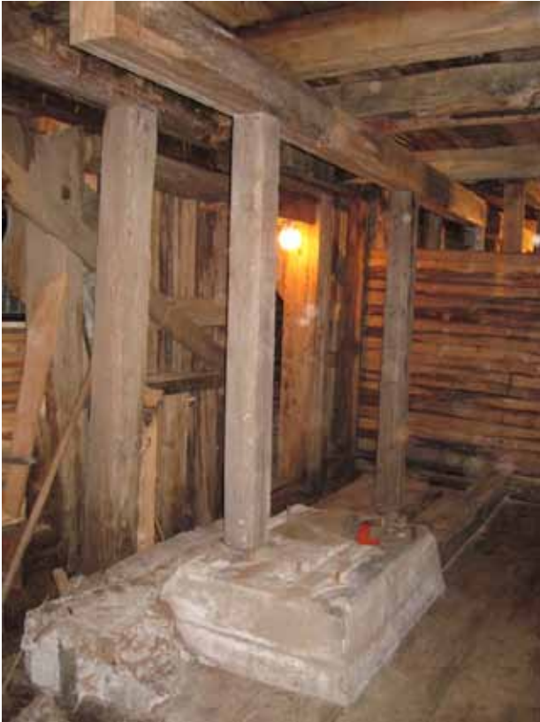
Det inre rummet i källarplanet. Den nya avbäringen vilar på de befintliga gjutna fundamenten från tidigare maskinell utrustning.
