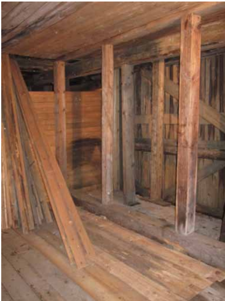
Även golv- och takbrädor fick bytas.
