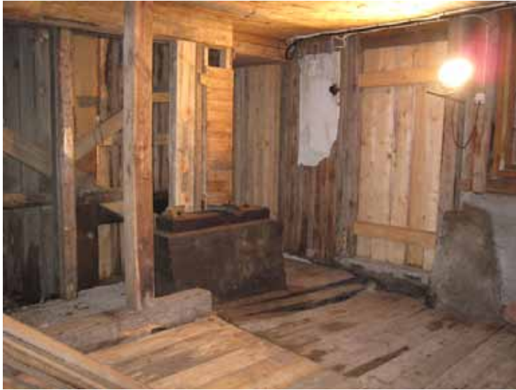
Rummet mot kvarnen. Lagningsarbetena är klara, mellanväggarna återstår att återmonteras.
