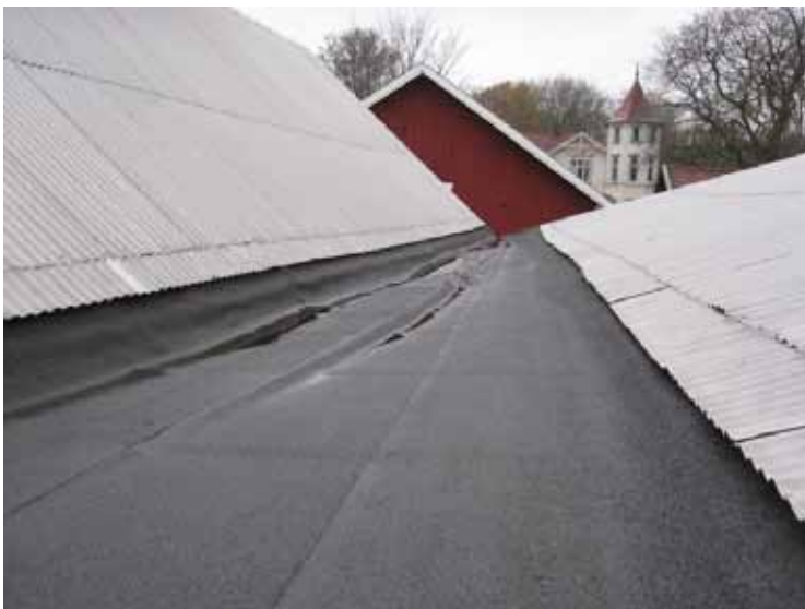
Taket efter tätad läcka.
