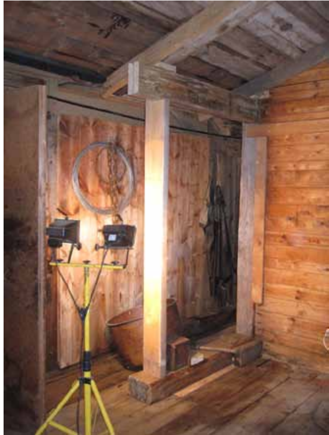
Avbäringen från utlastningsrummet.
