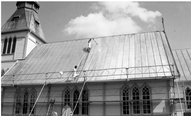
Kyrkans plåttak tvättas före målning.
