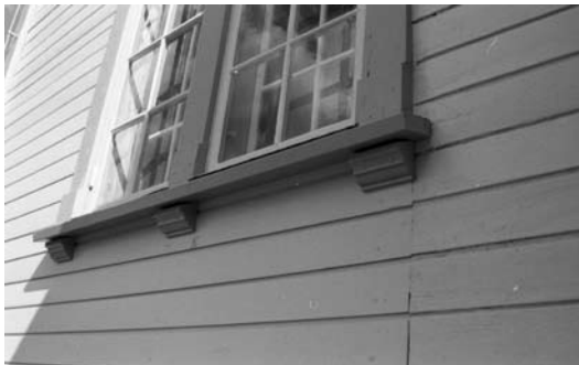
Den liggande panelen beställdes i en något avvikande bredd vilket försvårade passningen mellan den nya och gamla panytan.
