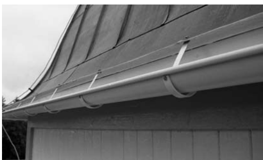
Torntaket försågs med avvattningsystem.
