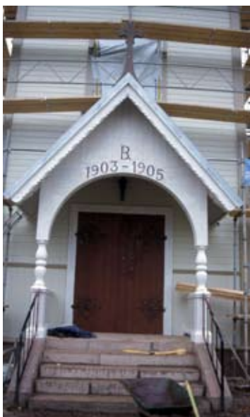
Tornet och brockvisten under ommålning.
