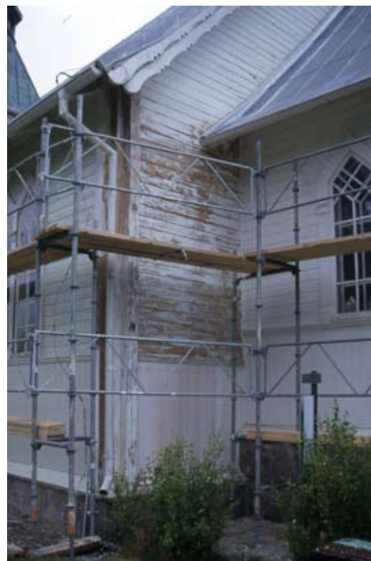
På långhusets västgavle och på kortet ersattes all panel i bröstningen.
