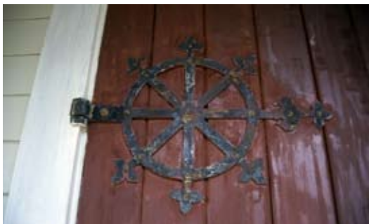
Detalj av huvudentréns port under ommålning.
