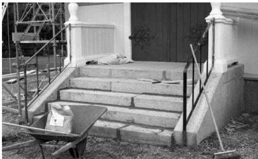
Entrétrappan sätts om och fogas med KC-bruk.
