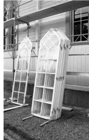
Fönsterbågar uttagna för renoivering.
