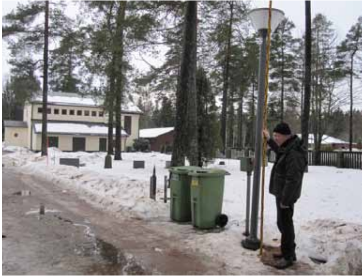
Vid besiktning av monterad provstolpe januari 2011 noterades att stolpen var högre än föreskrivet.
