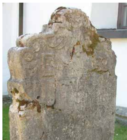
Kalksten har en förmåga att spjälka sig och spricka. Denna sten på Forserums kyrkogård i Nässjö kommun kräver insatser av en stenkonservator.
