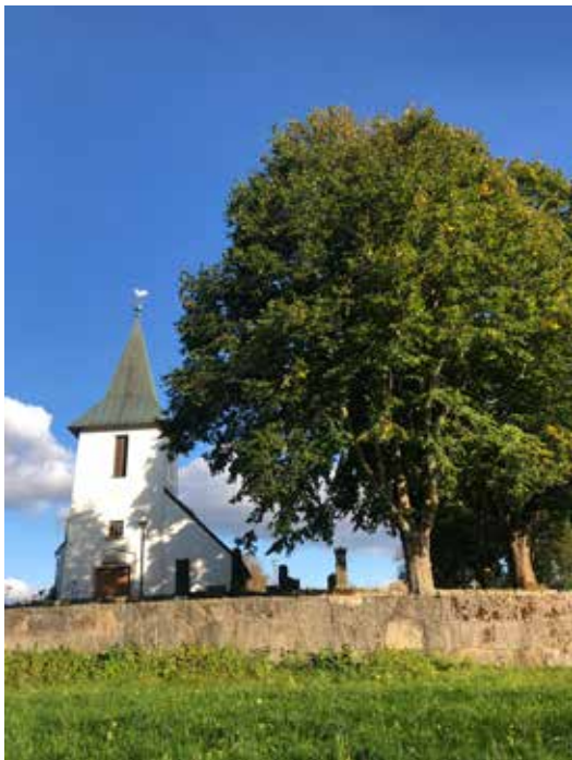
Kyrkogården utvidgades åt väster år 1968. Muren har en kraftig utformning av kilade granitblock, på insidan av muren står tre lindar varav ersatts under senare år.
